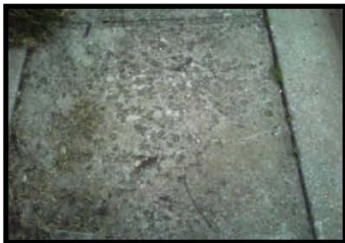
Spalling
